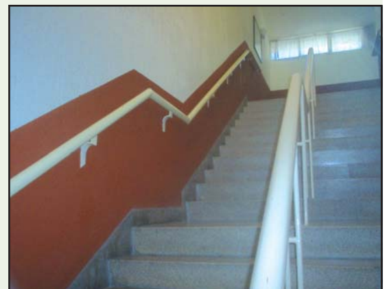
ZÓCALOS DE LA ESCALERA
